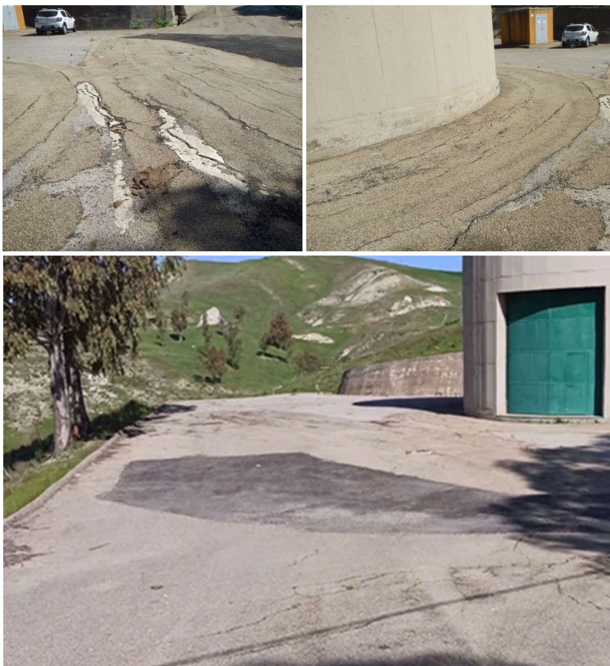
Figura 4.3: Diga di Gibbesi – Avvallamenti e lesioni del piazzale esterno
